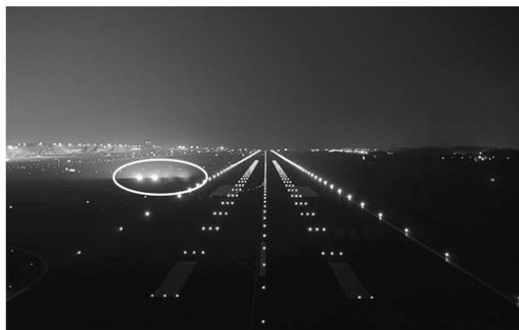
旅客機が滑走路へ近づく際の角度は「進入降下角」といい、どの機種でも  $3.0^\circ$  が適正となっている。旅客機は時速  $250\text{km}$  ほどで着陸するため、進入降下角がわずかに適正な角度からずれるだけで、安全な着陸が難しくなる。進入降下角を適正に保ったまま着陸するために、空港の滑走路脇には進入角指示灯 (PAPI) とよばれる 4 つのライトが設置されている。
